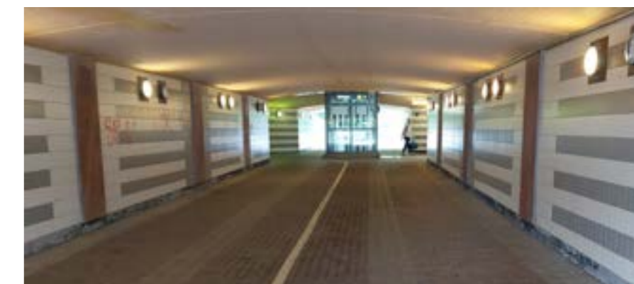
Ovan: Exempel på odefinierade och otrygga gång- och cykelvägar inom området. Nedan: Gång och cykeltunnel vid resecentrum med hisschakten i fonden.
