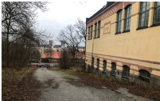
Fasad längs med Skolgatan sett från Kyrkogatan (Enköpings kommun).
