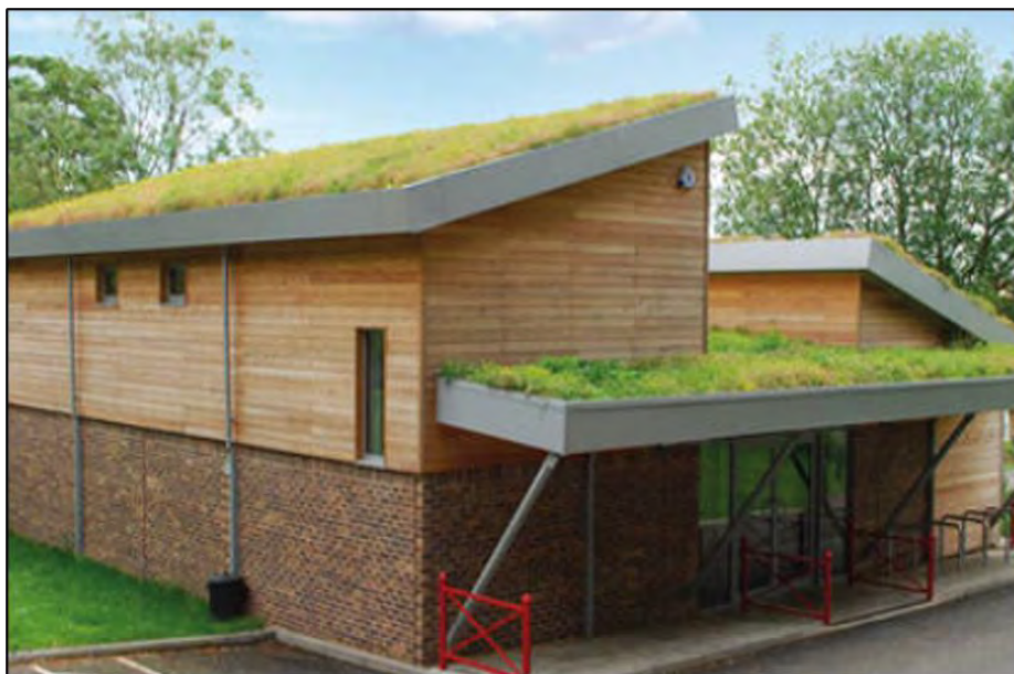
Figur 5-2: Grönt tak med sedumväxtlighet
